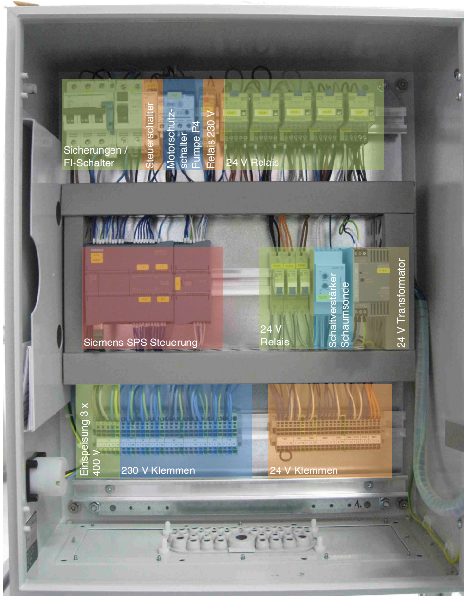
Abb. 33; Innenleben Steuerschrank
