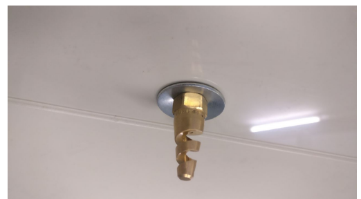
Abbildung 27: Schaumdüse im Reaktordeckel
